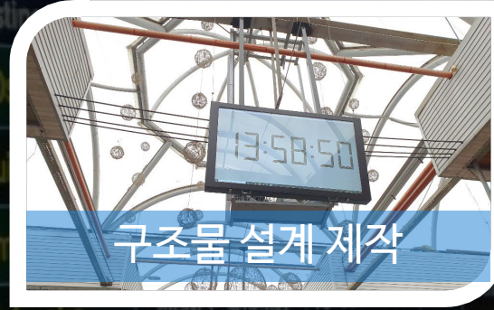
2. 영상장비 특수 구조물 설계, 제작, 시공
