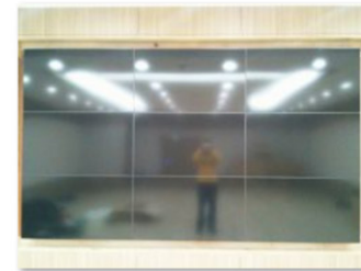
(동경티앤씨) 멀티비전 설치사례 (4)_가스공사.jpg
