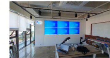
(동경티앤씨) 멀티비전 설치사례 (53)_제주두산.jpg
